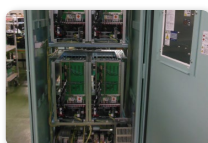
機器・配線組立
