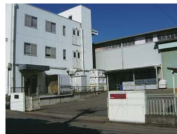
藤沢導波管製造工場
