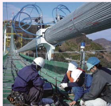
ボルト締結、軸力測定の様子
